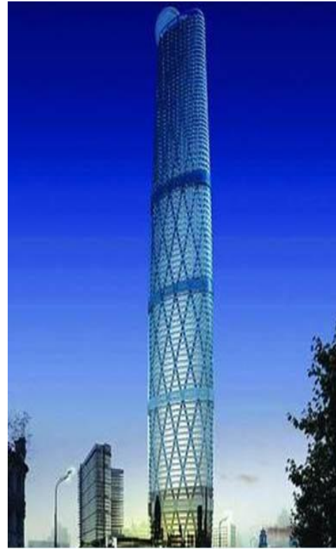
广州国际金融中心(西塔)
